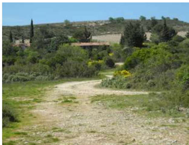
Bâtiment de l'ancienne mine - © ITEC
