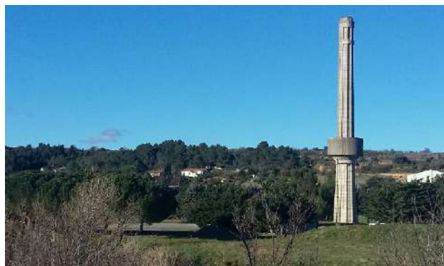
Cheminée de l'ancienne mine de La Caunette - © S. Brisa
