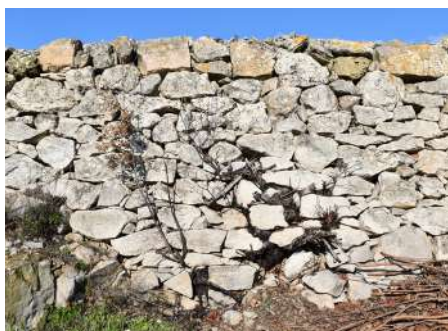
Le mur de pierre sèche traditionnel : – Mur avec des pierres de petite et moyenne taille, dont les appareillages peuvent être variés (incertum, assisé, en clavade) – Particulièrement adapté pour la réfection de mur existant
