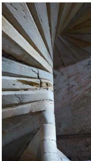
Escalier en vis du XVI e
