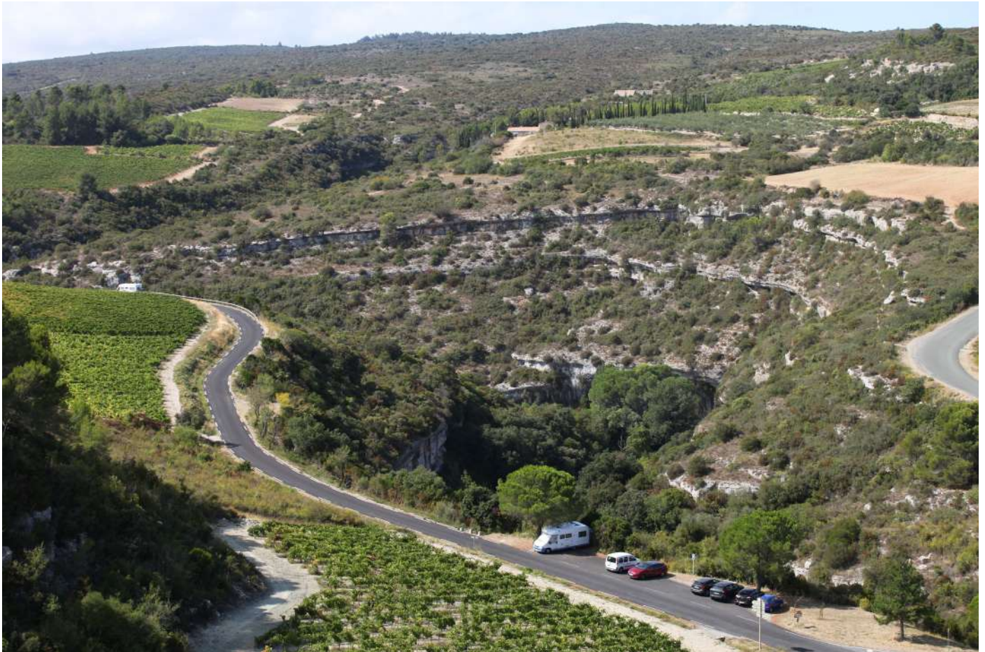
> Route départementale D10 en amont de Minerve. Une «route-paysage» qui longe les sinuosités de la Cesse
