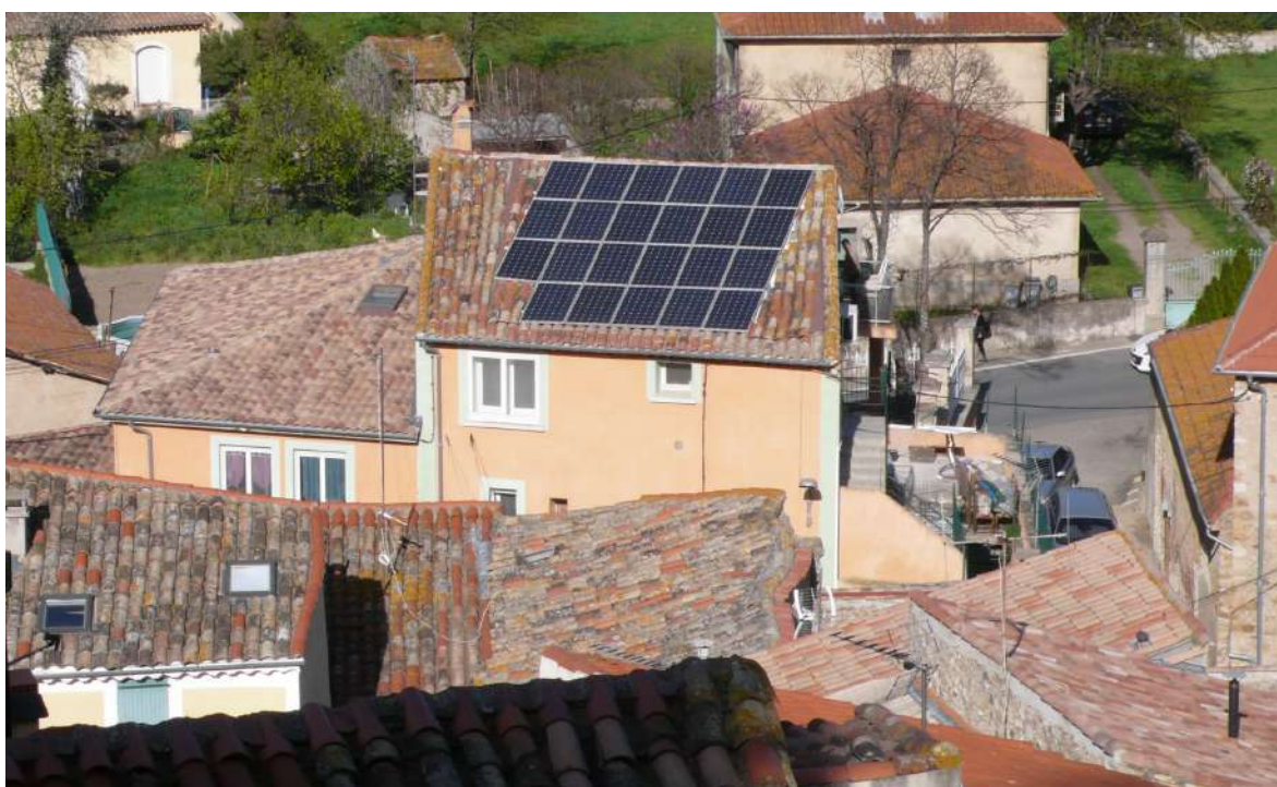
L'effet désastreux des panneaux photovoltaïques sur les toits des vieux villages
