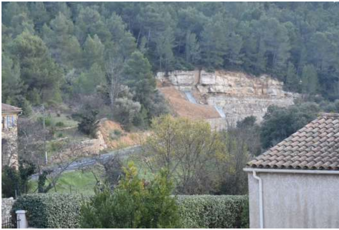
> Talutage et entaille dans la roche pour stabilisation des accotements de la route D175 à proximité du hameau de Paguignan
