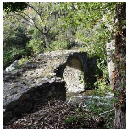
> Le pont du Moulin à l'aval de Minerve, récemment restauré par les habitants
