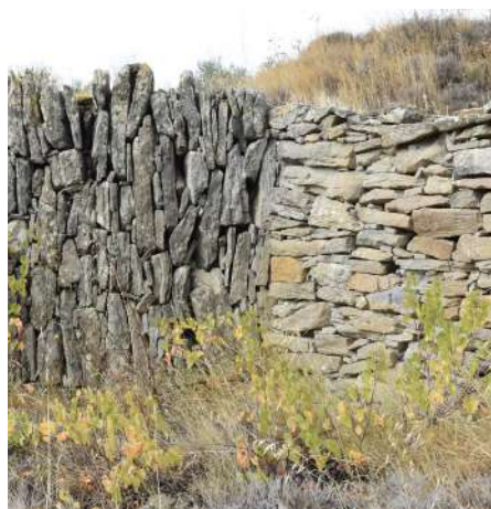
Opus clavé à gauche et opus assisé à droite
