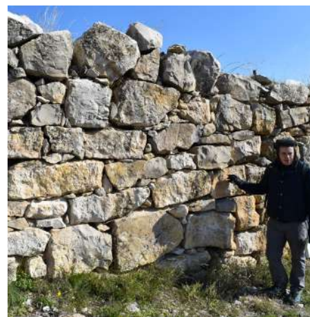
Opus incertum et cyclopéen (appareillage de pierre de gros calibre)
