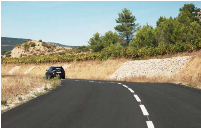
> Talus routiers dessinés et drains en enrochement
