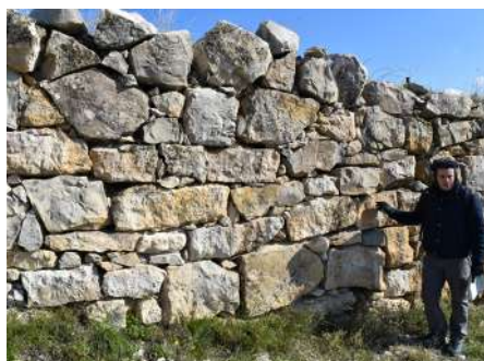
Le mur de pierre sèche cyclopéen : – Appareillage de pierres moyennes et de blocs imposants, de type incertum ou assisé – Particulièrement adapté pour les nouveaux projets de soutènement
