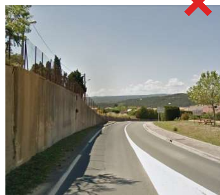
Le mur de soutènement en béton : un ouvrage moins perméable et banalisant
